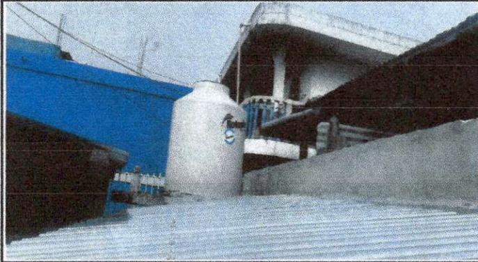
Foto 7: Sustitución de depósito de agua 1100 lt. Colocación de depósito de agua marca rotoplas de 1100 litros y accesorios.
