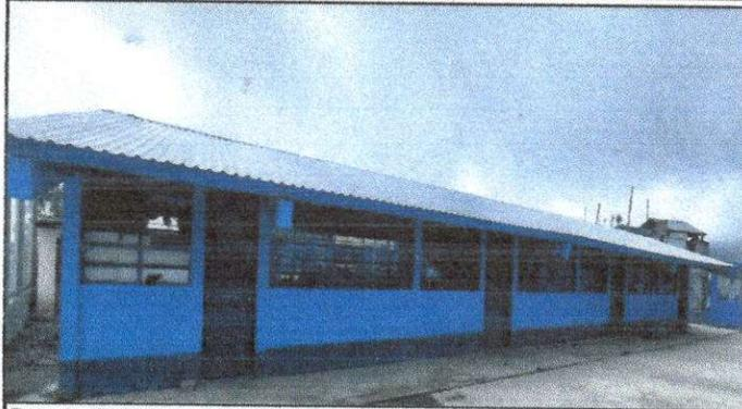
Foto 1: Trabajo terminado en la Sustitución de lámina por lámina troquelada aluzinc calibre 26, Sustitución de capote de lámina para lámina troquelada calibre 26 y Sustitución de elementos de fijación.
