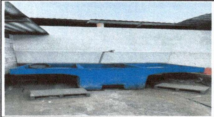
Foto 8: Sustitución de pila de cemento de dos lavaderos, con chorro y accesorios instalado correctamente
