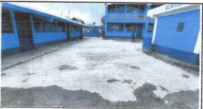
Foto 5: Reparación de planchas de concreto de patio 370m<sup>2</sup> satisfactoriamente terminado.
